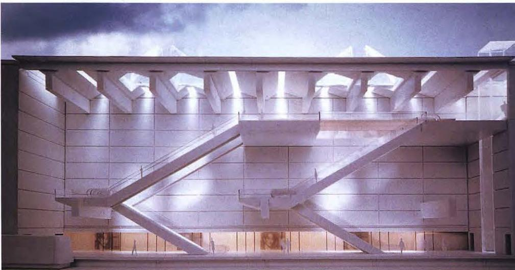
Modelo de estación de metro con tragaluces y escaleras que unen el nivel de calle con los andenes situados a 20 m de profundidad
